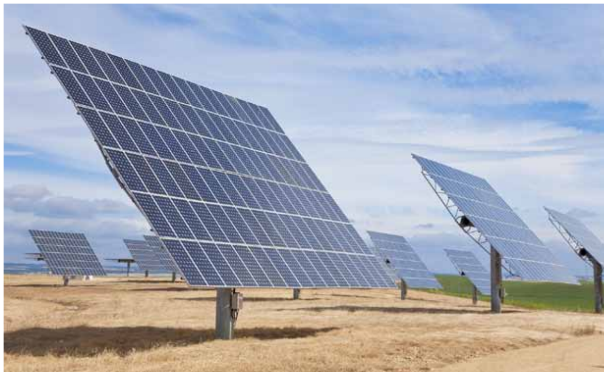
Placas de generación solar fotovoltaica.
