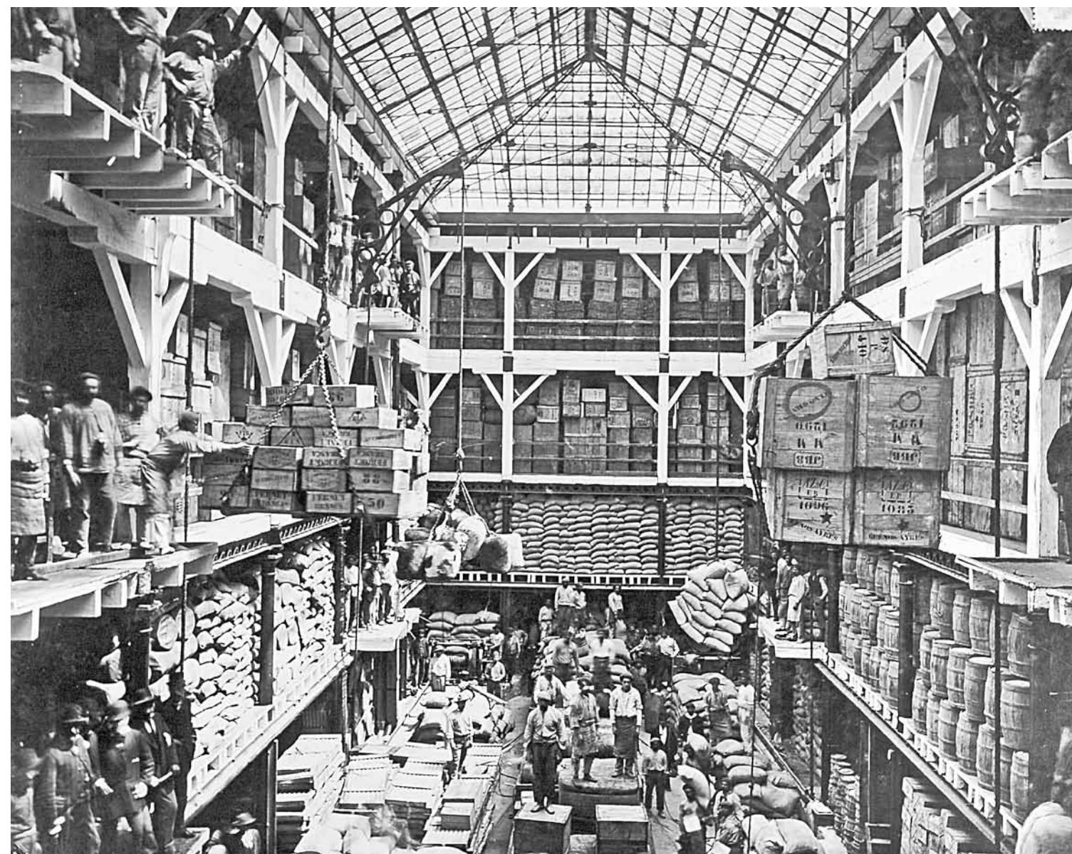
Imagen de un gran galpón de almacenamiento de productos diversos de la industria.
